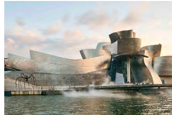
GUGGENHEIM BILBAO MUSEUM, Bilbao
